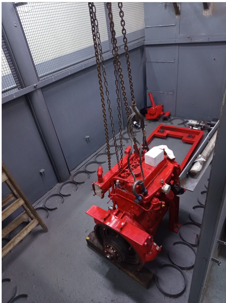
Moto-Bomba (Perkins 4-203) - Maniobra de Instalación y alineacion.
