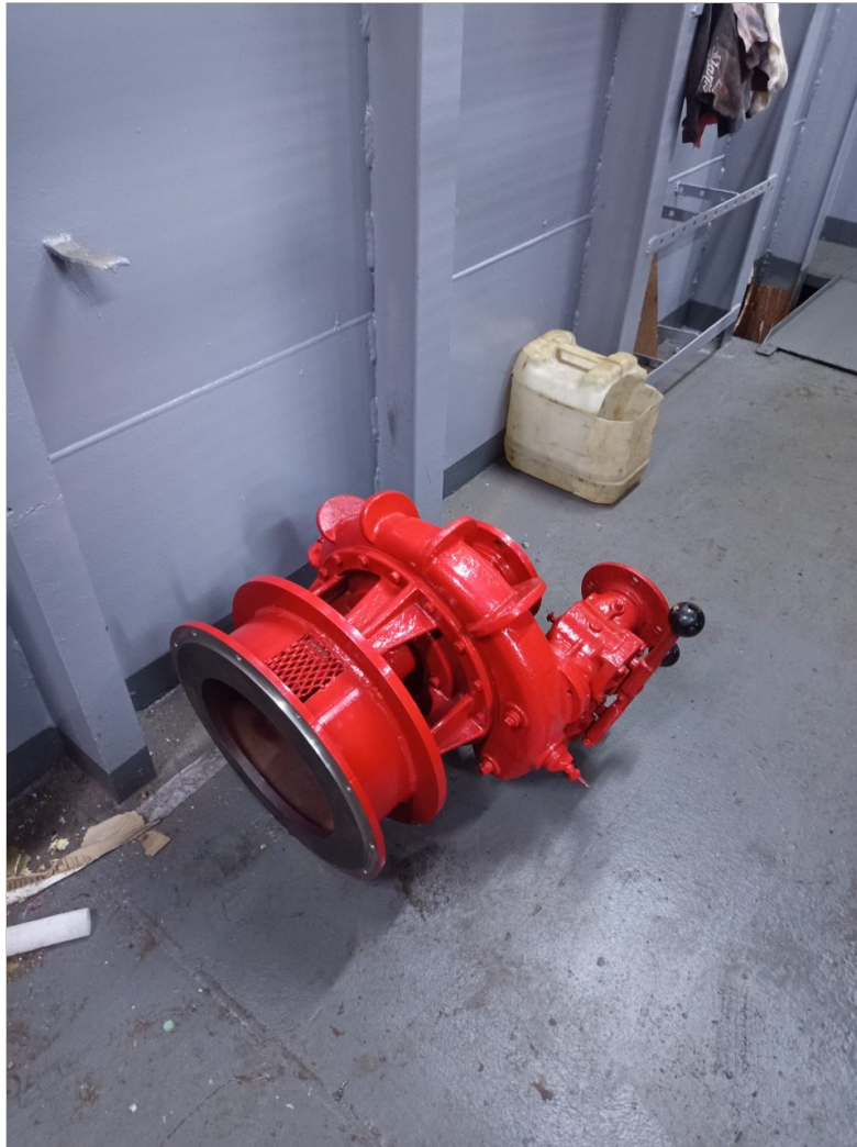
Moto-Bomba (Perkins 4-203) - Maniobra de Instalación y alineacion.
