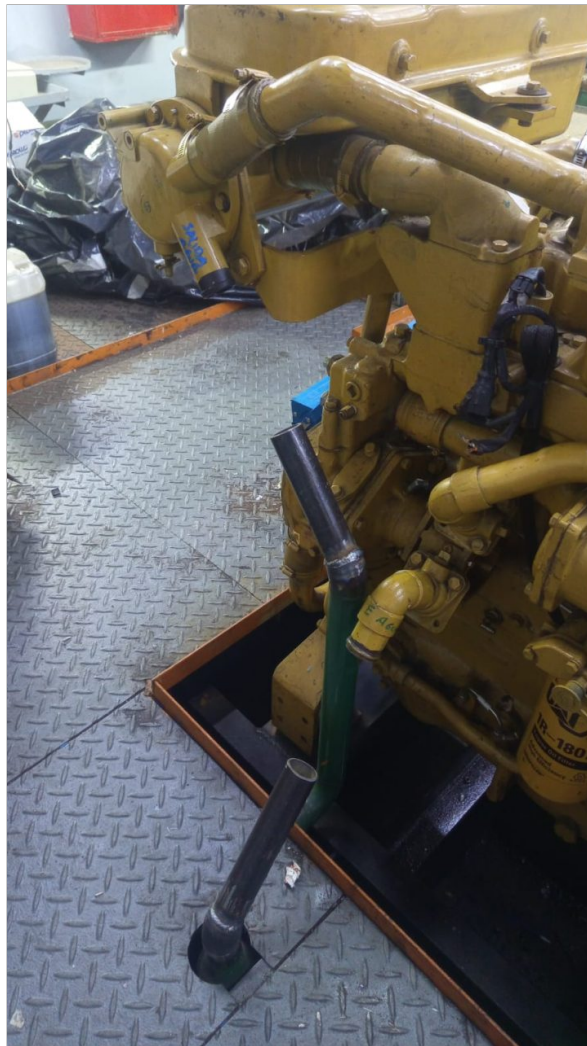
Instalación líneas de suministro de agua dulce.
