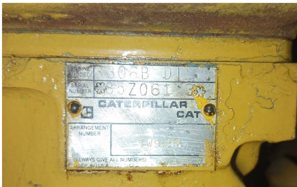
Generador 1 CAT 3306B - Placa identificatoria.
