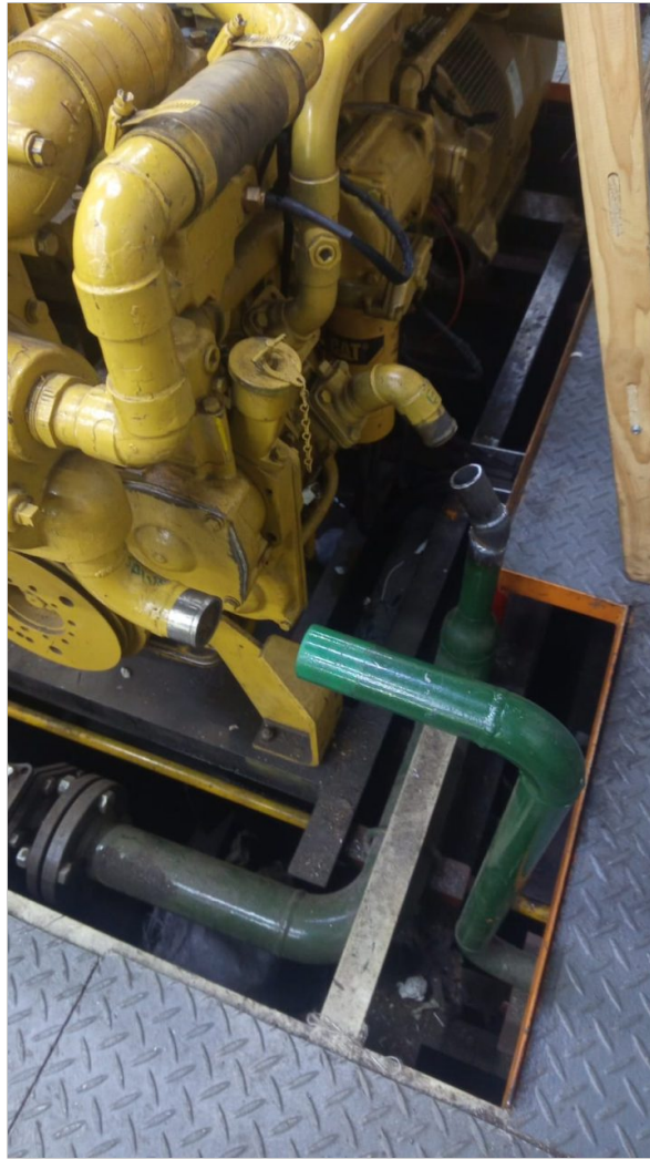
Instalación líneas de suministro de agua dulce.
