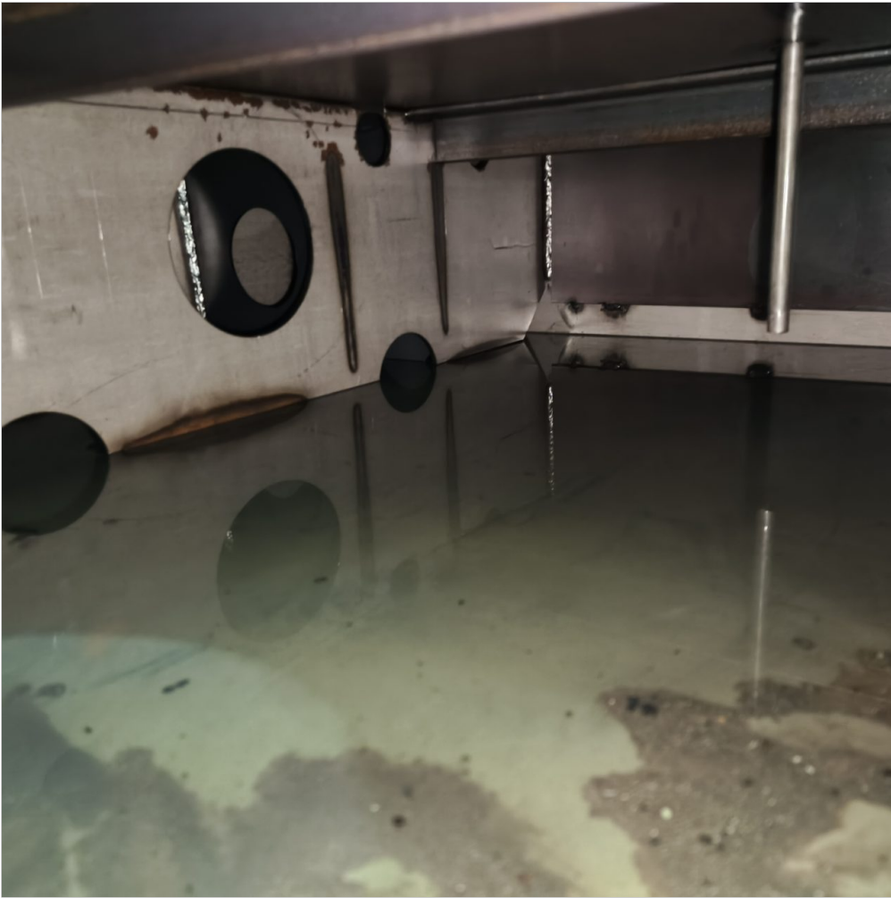
Tanque combustible - inspeccion estado interior operativo
