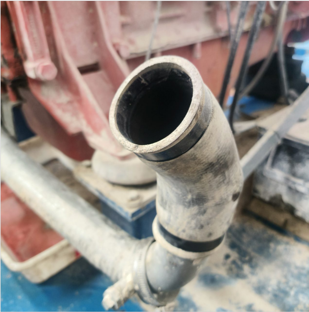
Mangueras y caños 2
