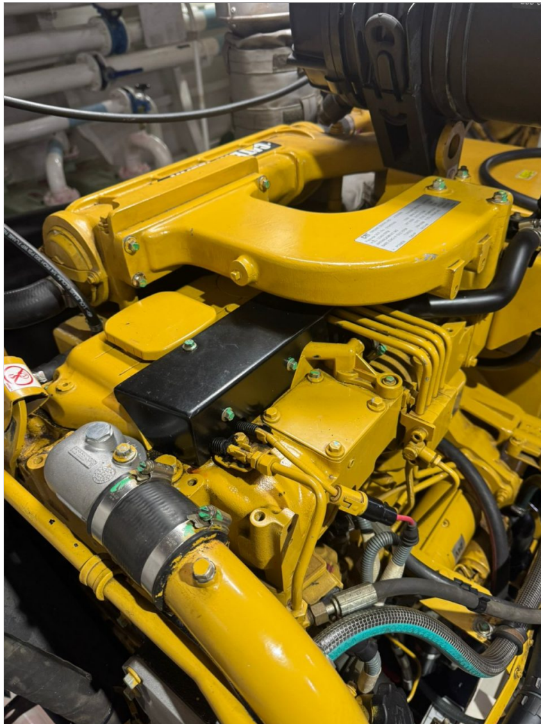
desmontaje y limpieza admisión
