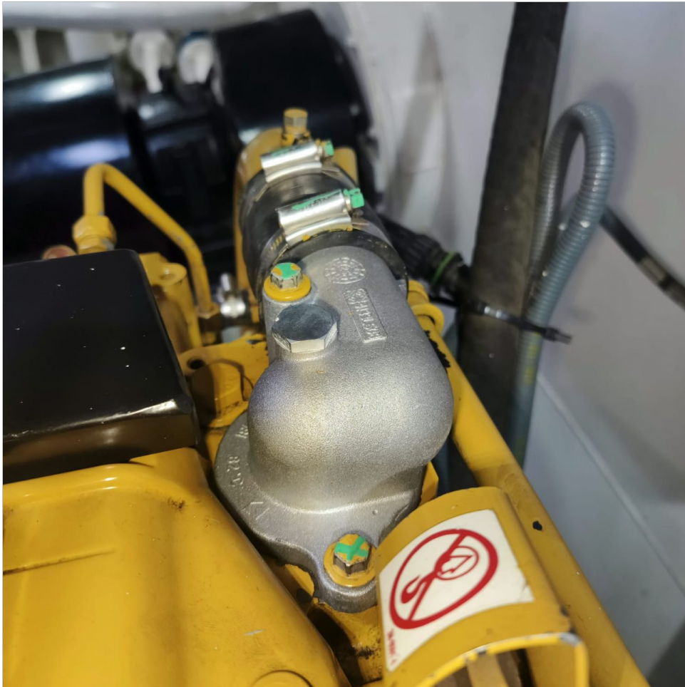
reemplazo termostato estribor
