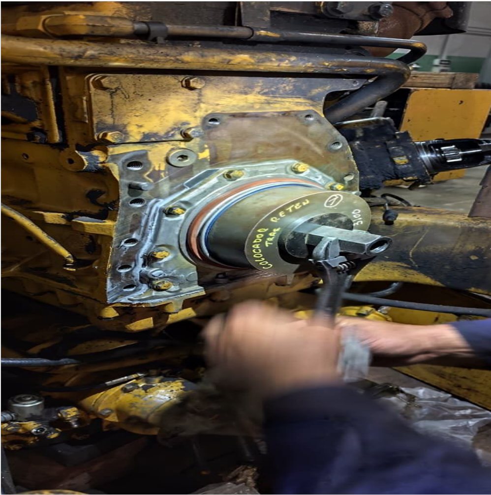
instalador de reten bancada trasero
