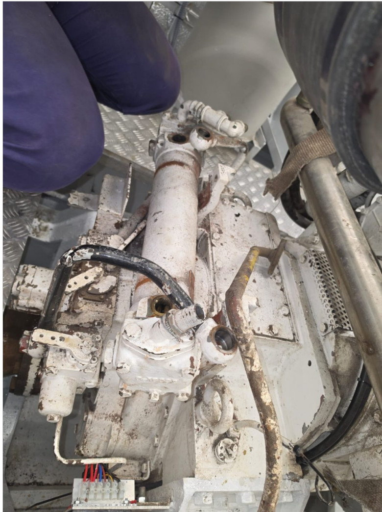
Desmontaje de enfriador de caja de transmision
