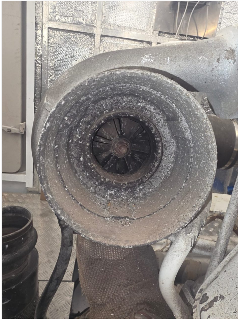
Inspeccion de turcocompressor
