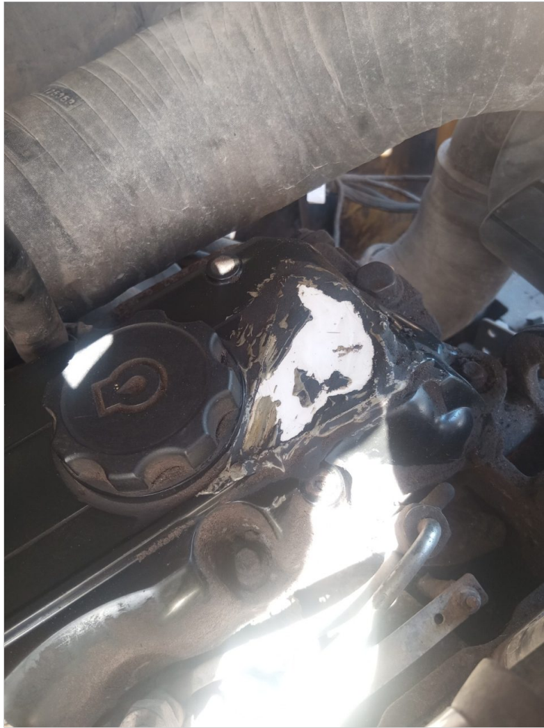
tapa de valvula dañado con fuga
