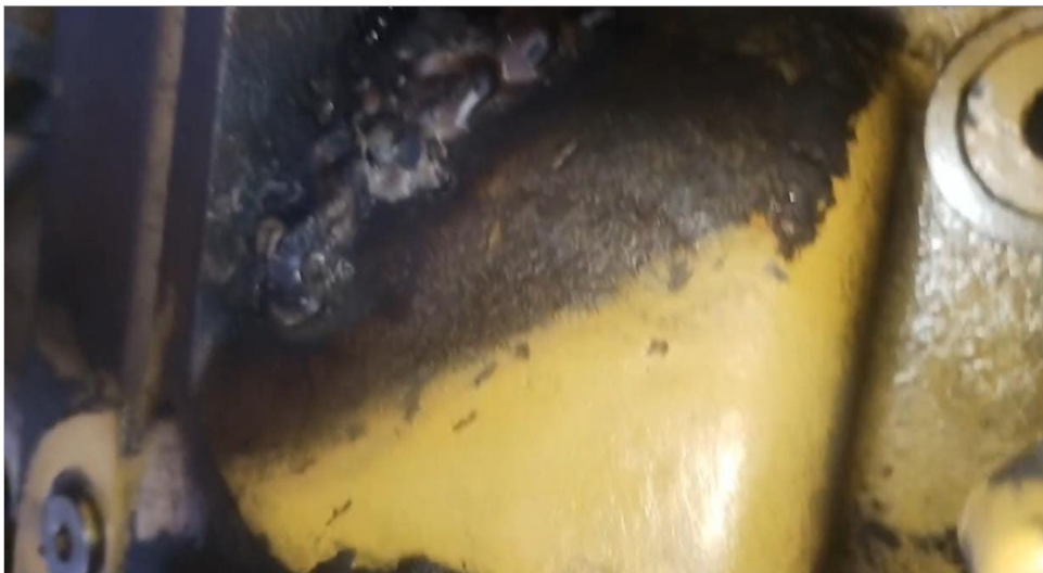
antes de reparar
