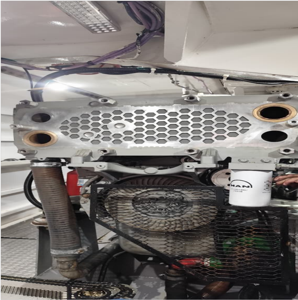
limpieza tanque compensador
