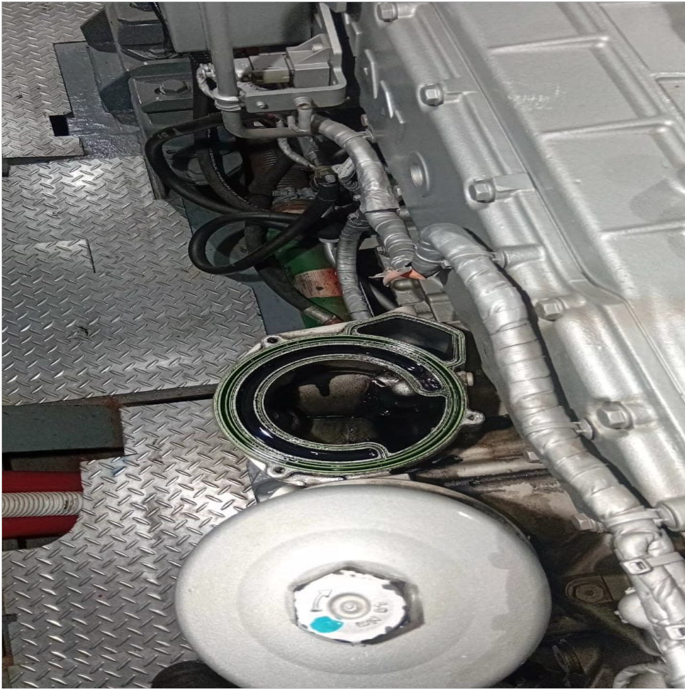
limpieza de sello montaje en recuperador de gases
