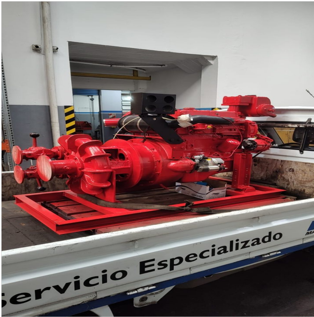
Se agrego tablero para instrumental y se pinto
