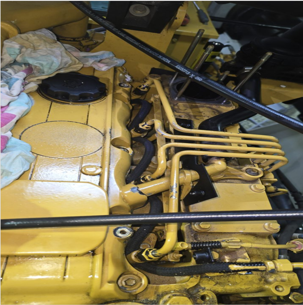
Reemplazo de manguera de retorno de combustible
